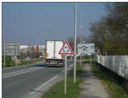
Cheminement doux le long de la RD939 bis
